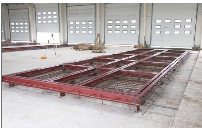
Fot. Kratownica do mocowania osprzętu naprawczego ustawiana jest przed wykonaniem posadzki w warsztacie. Fot. Herkules
